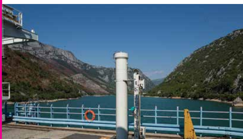
Pogled sa brane uzvodno, HE Salakovac
