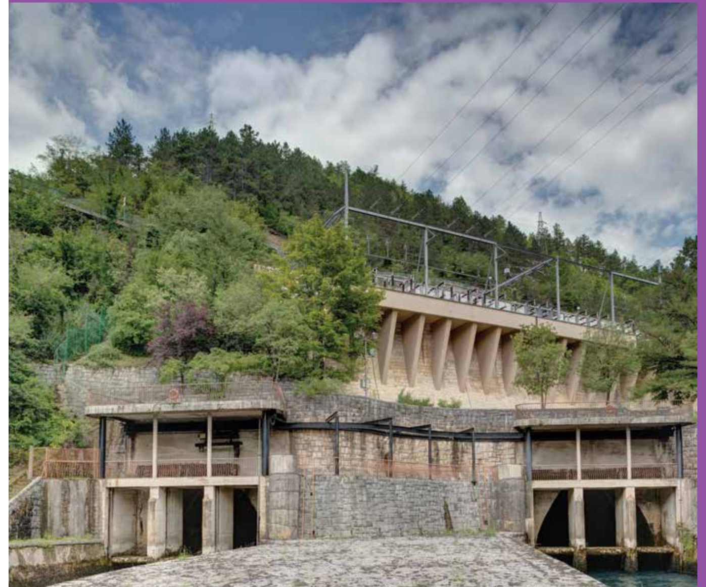
Razvodno postrojenje Hidroelektrana Jablanica
