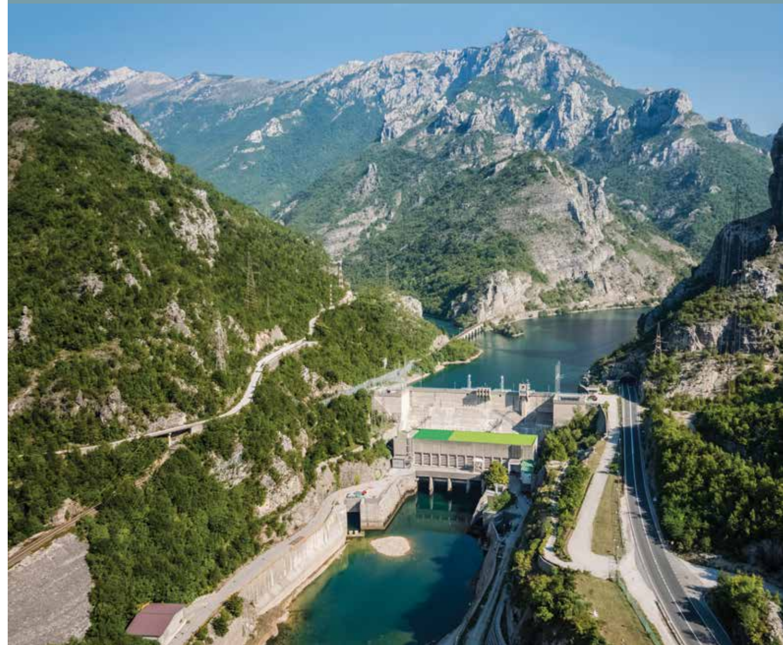
Hidroelektrane na Neretvi/ Hidroelektrana Grabovica
